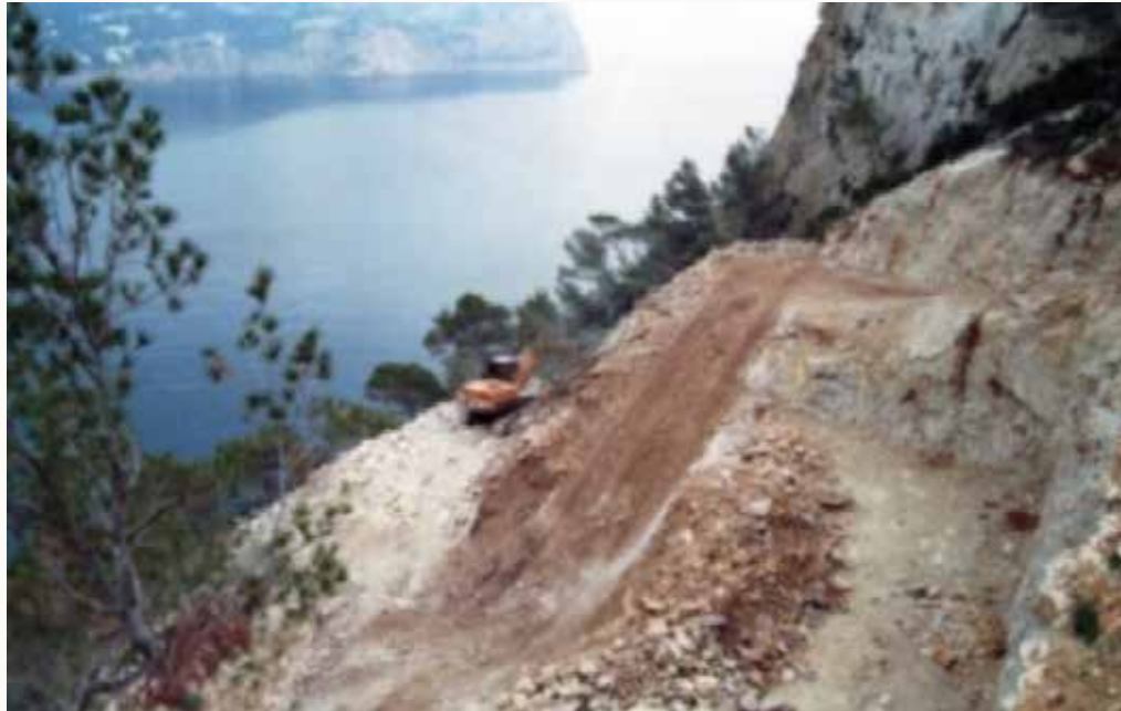
Baustelle Liedtke Museum Puerto de Andratx
